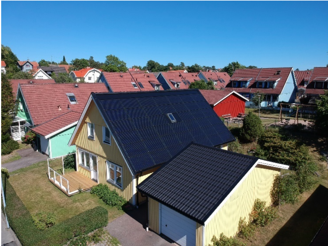
Figur 14 Ett exempel på när ett snörasskydd kan vara motiverat även i syd- och Mellansverige. Bilden visar en takintegrerad anläggning med solcellsmoduler i standardformat
