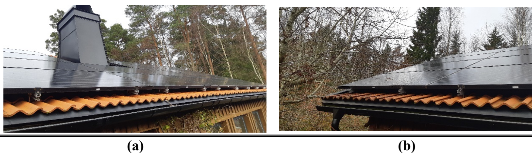
Figur 27 Kraftig skuggning från en skorsten och från omgivande träd både i öster och väster har reducerat energiutbytet kraftigt.
