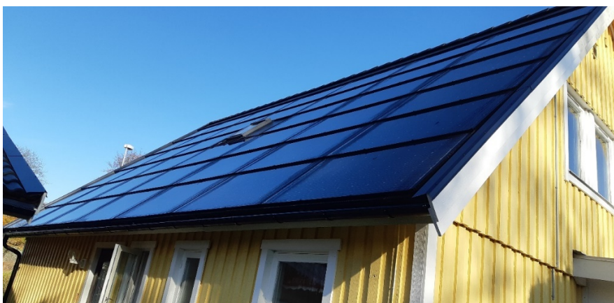
Figur 29 Byggnadsintegrerade moduler på anläggning 25
